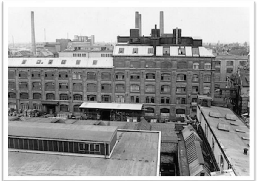
Kabelwerk Oberspree in Berlin-Oberschöneweide
